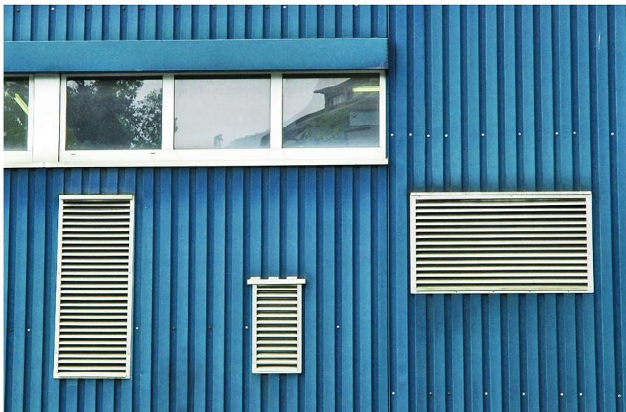
Les grilles pare-pluie Ohnsorg sont constituées de lamelles résistantes aux intempéries et d'une grille de protection en Inox à l'arrière. Elles sont installées en façade ou sur un caisson de toiture et sont, de par une fabrication très soignée, d'une agréable qualité visuelle.
